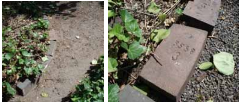
Figur 95. På båda sidor om "vedplatsen" kantas stigen av mjukt avrundade rader marktegel. På norra sidan (t. v.) är stenarna utan märkning, på östra sidan kring syrénen (t. h.) är de försedda med siffermärkningen '3558 3'. Foto: 080625.
