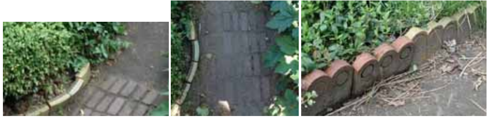
Figur 41. Från vänster den spetsigt avrundade kanten satt med enkel glaserad kantsten, och intill den en yta satt med fyra rader småtegel. Till höger detaljbild av den andra typen glaserad kantsten i rött och gult, formgiven av Signe Persson Melin. Foto: 080626.
