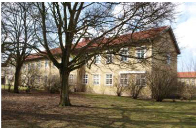
Figur 135. Byggnad 4 från sydöst.
