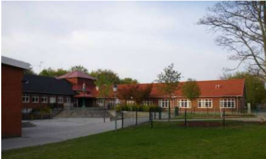
Figur 30. Backaskolan (B25). Innergården på sydöstra sidan, foto från syd-sydöst.
