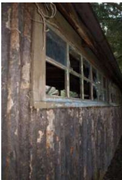
Figur 64. T.v. "solgångens" fasad täckt av ytterbrädor av obarkad "bakved/bakar" av gran. originalfönster. T.h. kalkstenstrappa mot nordöst.
