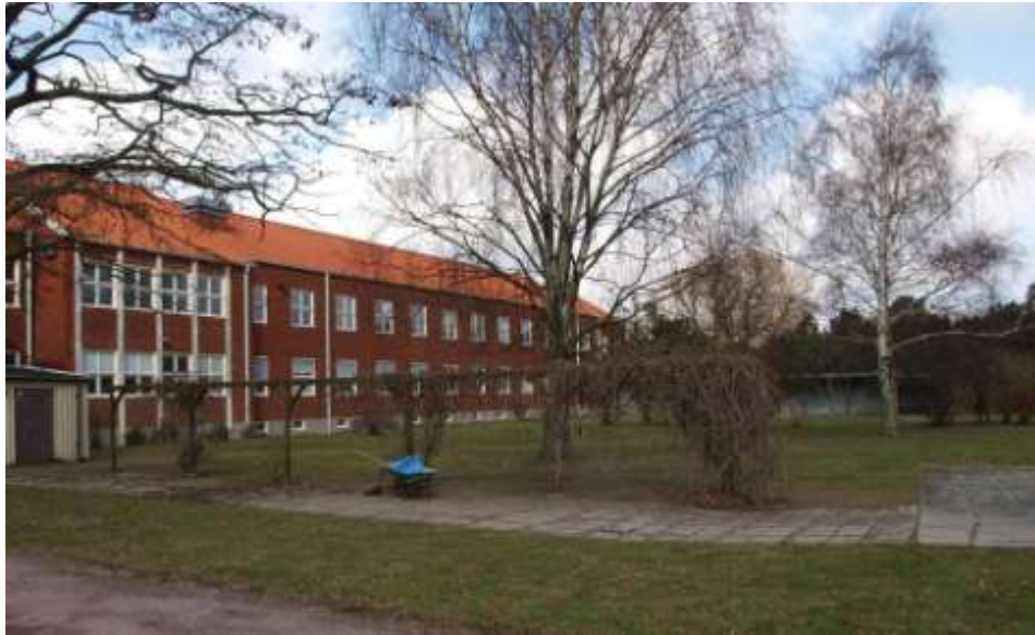
Figur 54. Byggnad 5a från sydväst. Pergola med klängväxter, yta med cementplattor, stora träd och buskar, intill husgrunden en smal rabatt med bland annat rabarber.
