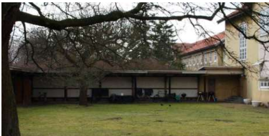
Figur 132. ”Solgången” vid byggnad 4 från nordöst.
