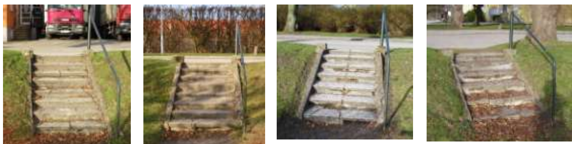
Figur 102. De fyra trapporna mot allén, också från sydöst till nordväst. Den första och tredje från sydöst har steg av rektangulära cementplattor medan den andra och fjärde från sydväst har steg av kvadratiska cementplattor. I övrigt är de lika med sidostycken av kalksten och enkla räcken av grönmålat böjt metallröd på vänster sida då man går ner. Alla trappor har alltså räcke på sydöstra sidan oavsett placering.
