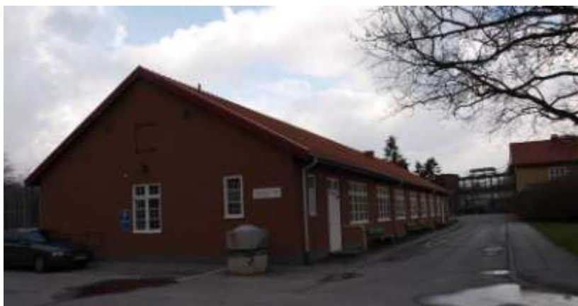
Figur 124. Byggnad 10 från sydöst.
