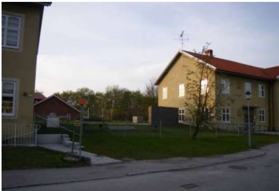
Figur 40. Yta mellan B1 och B3 från S och den centrala gräsaxeln. Det lilla trädet till höger är gammalt trots sin storlek, sannolikt en ovanlig hagtornsart ( Crataegus sp.).
