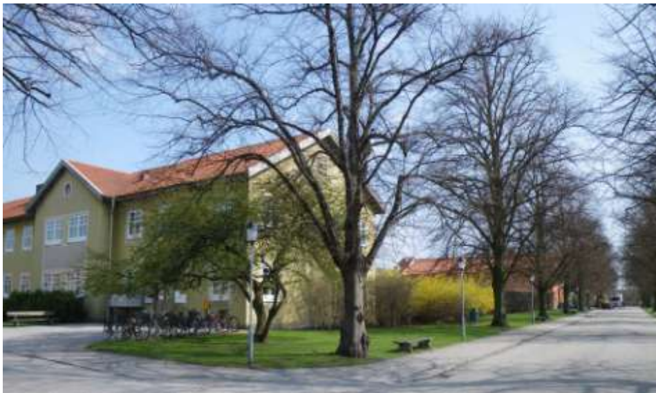
Figur 119. Byggnad 2 från nordväst. Till höger allén.
