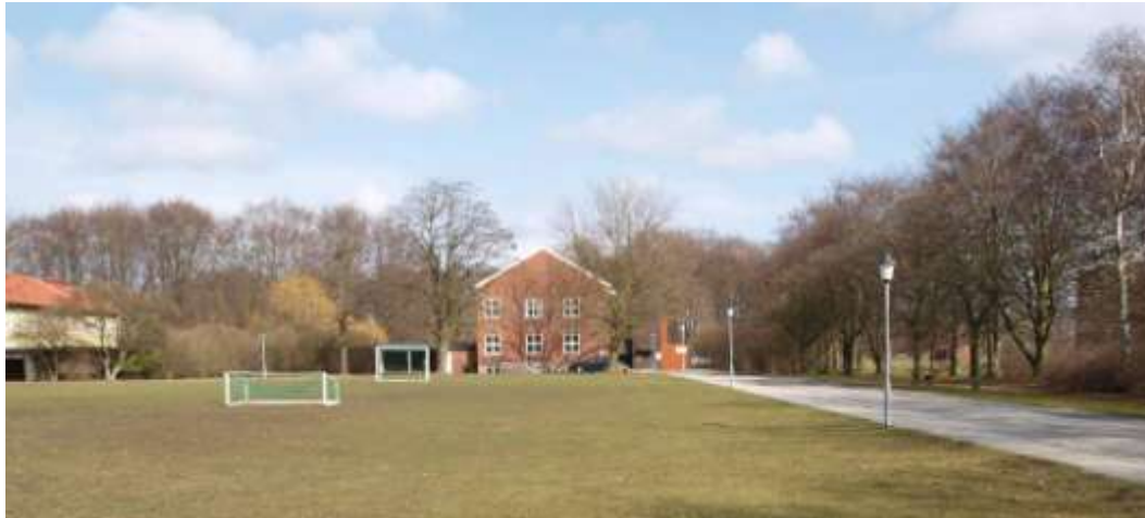
Figur 154. Byggnad 8a från sydväst. Till vänster syns även byggnad 8.
