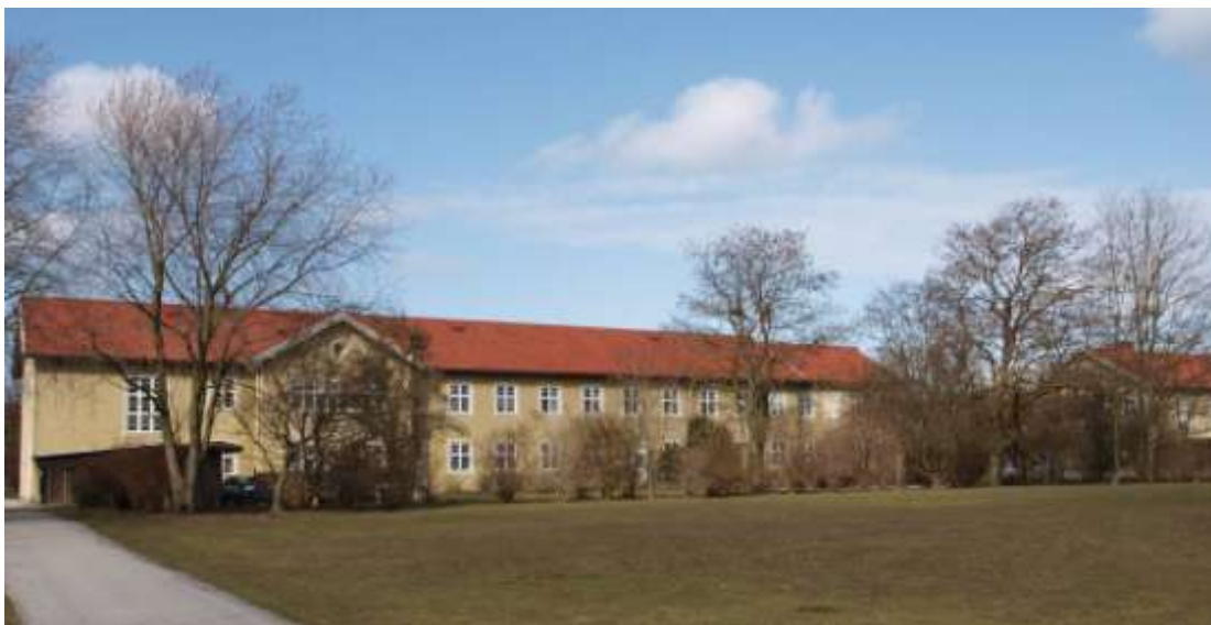
Figur 141. Byggnad 4 från söder. Till vänster skymtar även byggnad 6. Söder om byggnaden syns även den stora öppna gräsyta som ligger intill.
