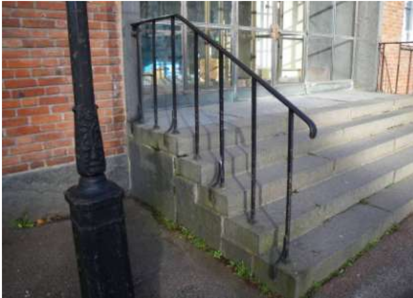
Figur 72. Detalj entrétrappa av natursten, fot till lyktsolpe och trappräcke av metall.
