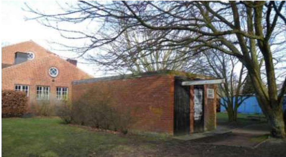
Figur 80. Telefonväxelbyggnaden från väst, t.v. i bakgrunden kyrkan.
