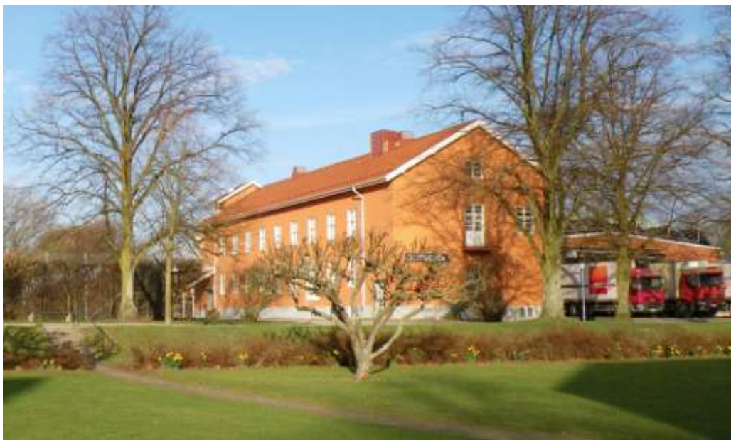
Figur 165. Köksbyggnaden (B17) från nordväst.
