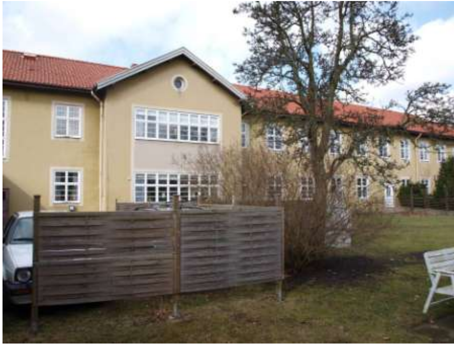
Figur 144. Byggnad 6, trädgårdens västra del från syd-sydöst.
