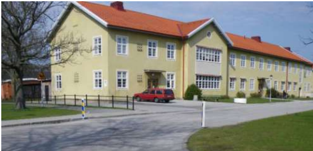
Figur 36. Byggnad B1 från sydväst. Till vänster syns ett träd i trädraden vid kyrkan, och bakom detta skymtar den bevarade yttre fasaden till byggnadens "solgång".
