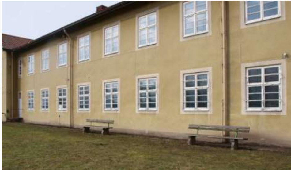
Figur 149. Byggnad 8, vägg mot sydöst från söder. Vid väggen en rabatt kantad av kalksten. Vid den två bänkar, i anslutning till rätlinjiga igenvuxna sandgångar.
