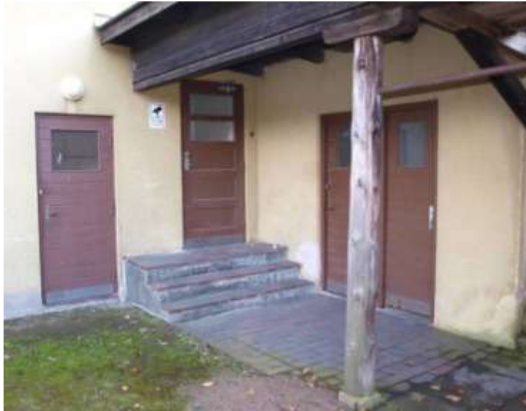
Figur 65. Anslutning byggnad och "solgång" B7. Färg och material original.
