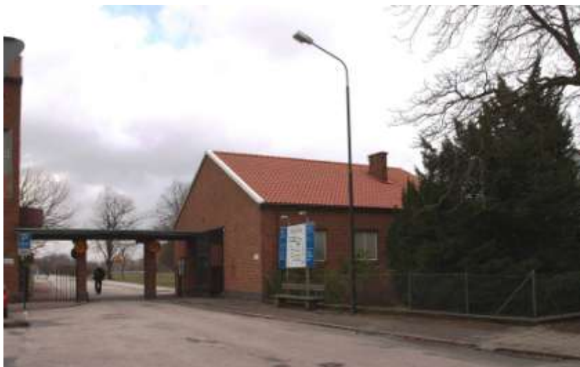
Figur 224. Entrén från sydväst skulle göras trevlig och inbjudande om de två trädgårdarna vid sidorna, den vid administrationsbyggnaden (B23) och den vid den lilla vaktmästarbostaden (B23) mitt i bild restaurerades. Entrén och vaktmästarbostaden är karakteristiska detaljer som bör bevaras.
