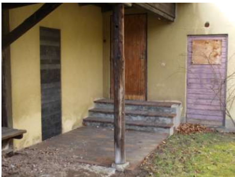
Figur 153. Byggnad 8, anslutning mellan "solgång" och hus är välbevarad.
