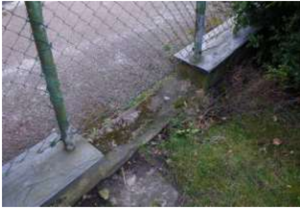
Figur 77. Detalj igensatt öppning, se även Figur 74&76.
