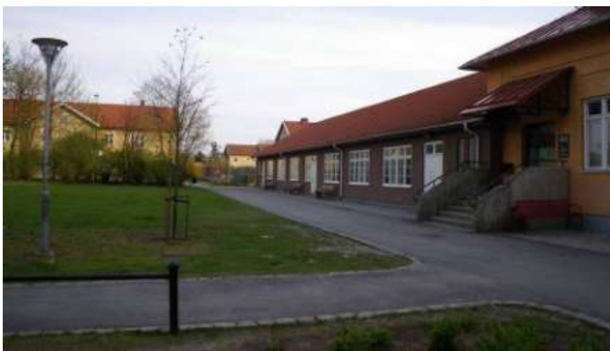
Figur 32. Backaskolan (B25) östra sidan. Terapibygnaden har integrerats i den nya skolan. Vid väggen står tre nyttillverkade soffor i typisk stil för området. Foto från norr.
