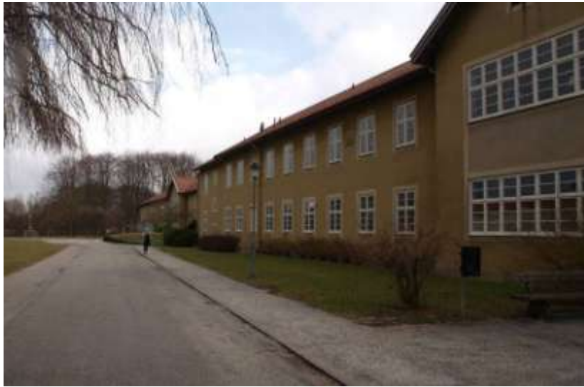
Figur 138. Byggnad 6 från sydväst och den centrala axeln. I bakgrunden B8 och parken.
