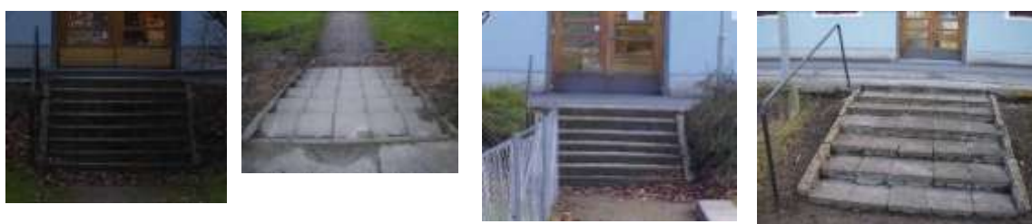
Figur 101. De fyra trapporna mot B11 & B12 från sydöst till nordväst. Dessa har steg av cementplattor, sidostycken av kalksten och enkla räcken av grönmålade böjda metallrör, på höger sida då man går ner.
