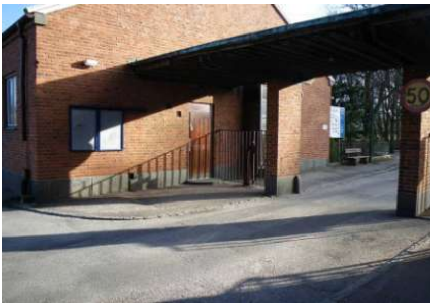
Figur 88. B22 fasad mot entrén fotograferad från norr.
