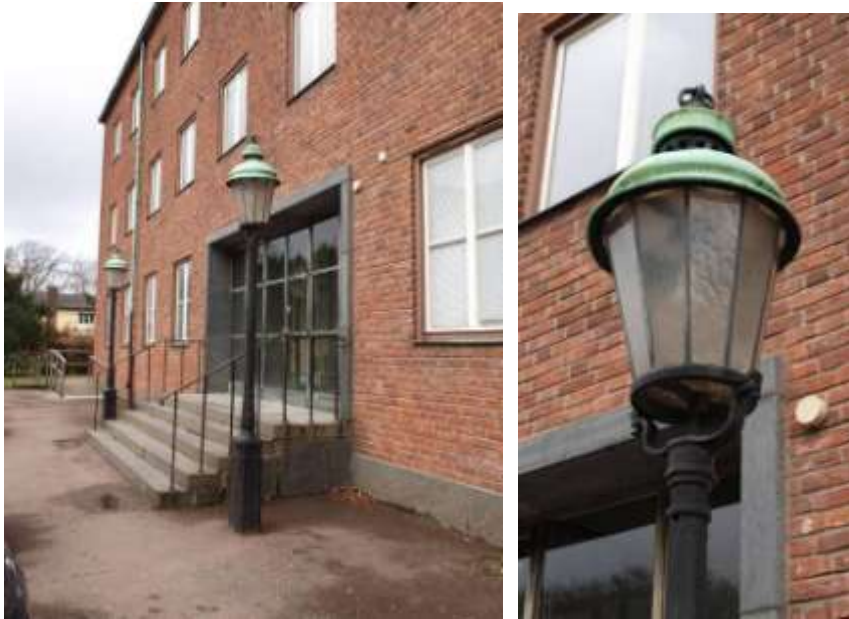
Figur 71. Entré till administrationsbyggnaden (B23) från Östra Fäladsgatan. Påkostade gatlyktor.
