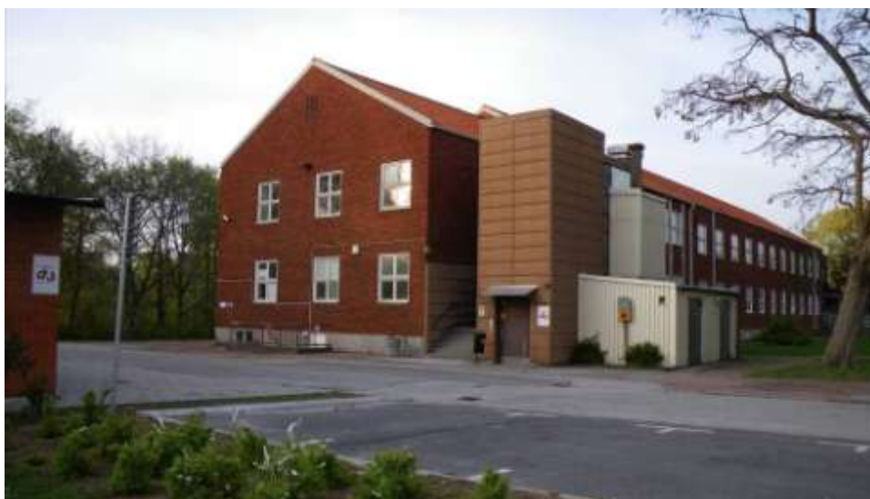
Figur 56. Byggnad B5a från sydväst. Trottoaren täcks av fläckvis bevarad röd asfalt.
